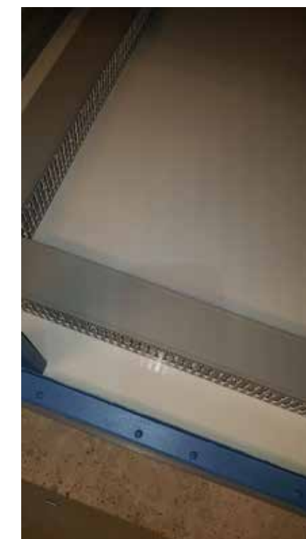
Nieuwe kabelgoten maken het geheel af.
