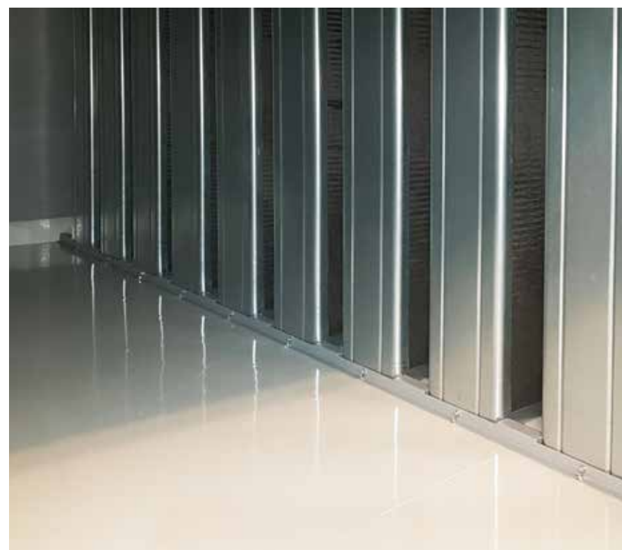
De toegepaste gietcoating zorgt voor een gladde en naadloze vloer.
